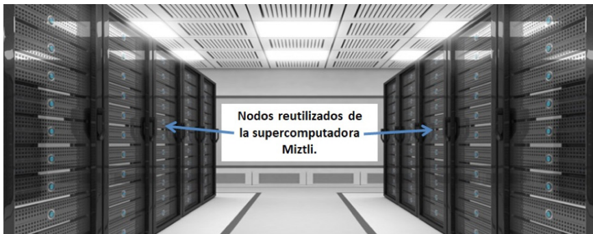
Figura 14. Centro de Datos de DGTIC reacondicionado.
